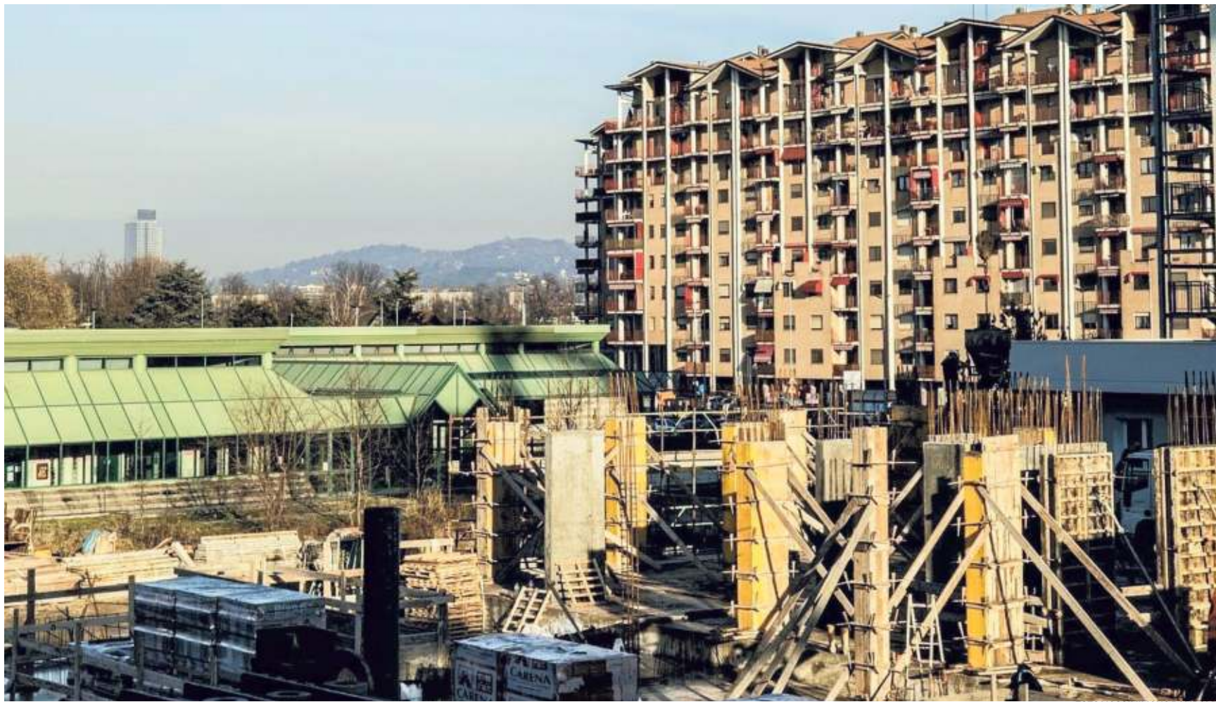
Il cantiere del condominio, costruito dalla cooperativa Giuseppe Di Vittorio e che sorgerà accanto al poliambulatorio dell'Asl
